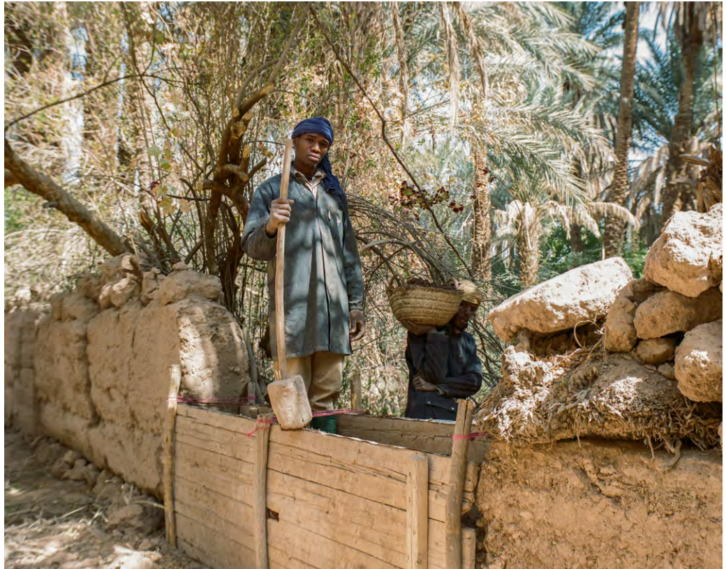
Ali és un dels últims artesans de l'oasi d'Akka que practica la construcció tradicional amb fang, febrer de 2021.
